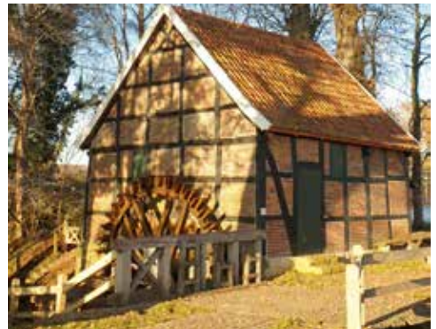
Mühlensingen, Hesemannsche Wassermühle, Handrup, Zur Wassermühle
