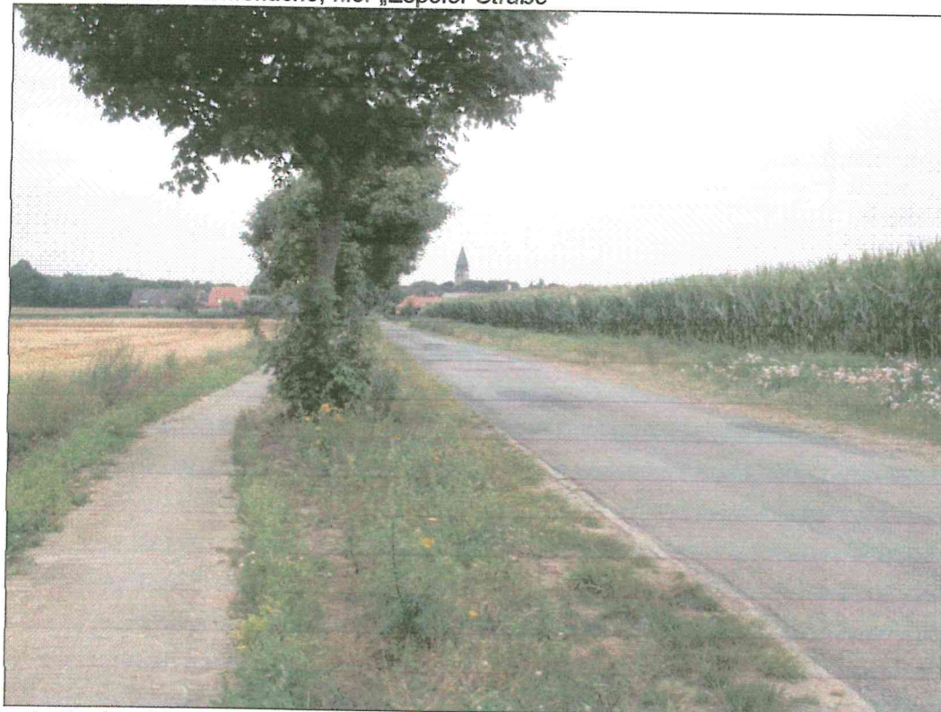
Espeler Straße mit begleitendem Radweg und Baumreihe aus Bergahorn (Blickrichtung Norden); rechts Ackerflächen mit Mais, im Hintergrund Ortschaft Langen
